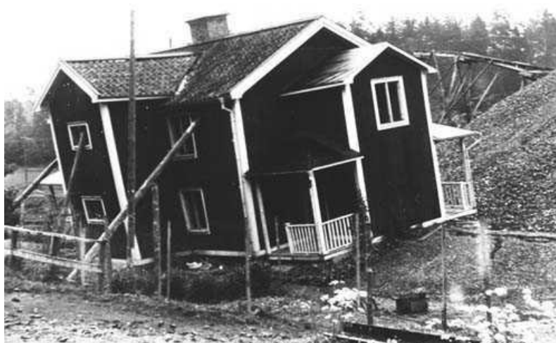
Stensbergshuset, som höll på att stjälpas p.g.a. malmtrycket.
