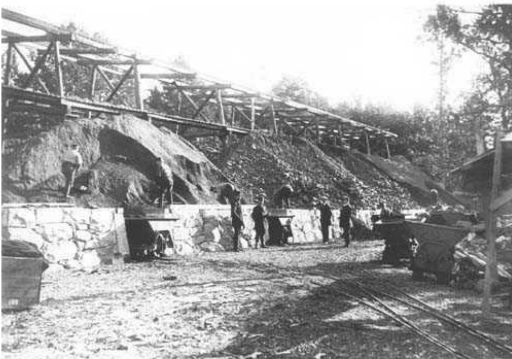
Ändstation för linbanan och omlastning vid kajen, Björnvik.
